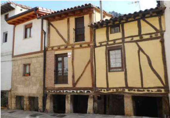
Pancorbo, village typique de montagne avec son cheminement sous les maisons pour se protéger de la chaleur et de la neige
