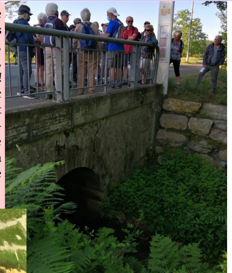
Sous le pont de Brique, l'eau canalisée, donne naissance à l'Eau Bourde, Cestas
