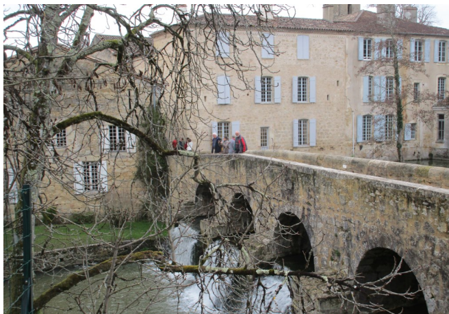
Pont Daurat : le pont barrage
