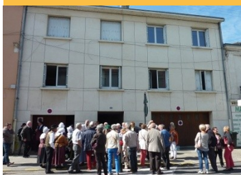
L'immeuble qui abrite le gîte
